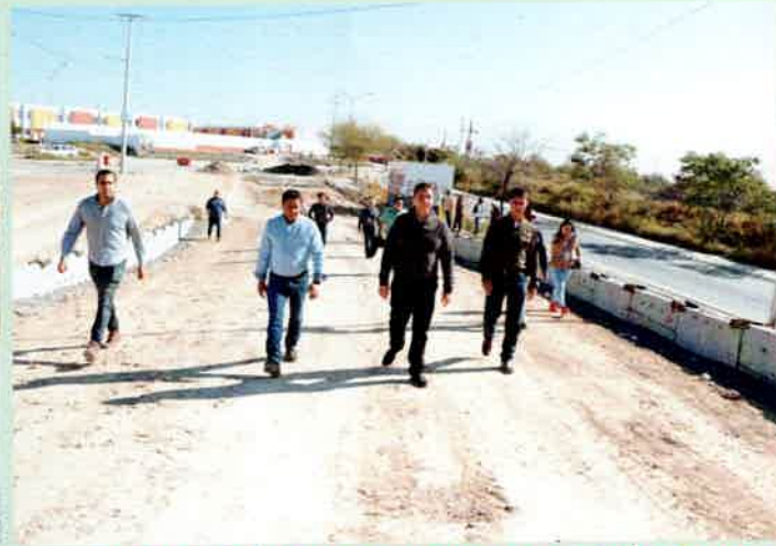
SUPERVISA OBRA FRANCISCO TREVIÑO CANTU DEL "PUENTE LOCO" EN JUAREZ, N.L.
