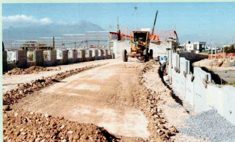
NOTORIO AVANZE AL "PUENTE LOCO" EN JUAREZ, N.L.
